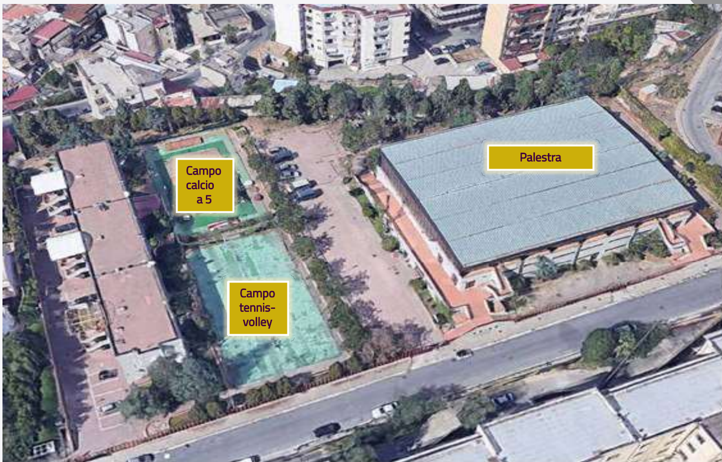
Ortofoto 2 – Vista aerea con particolare dei campi polivalenti
