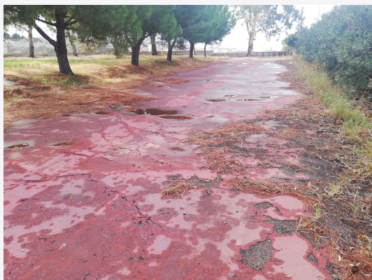
PISTA DI ATLETICA IN STATO DI ABBANDONO
